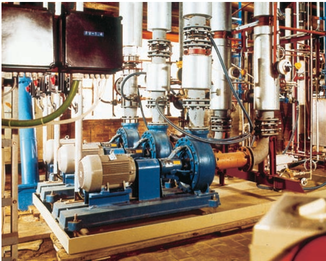
Chemie-Normpumpen Typ RNSi aus Eisen-Siliziumguß in einer Dünnsäure-Eindampf-Anlage.
