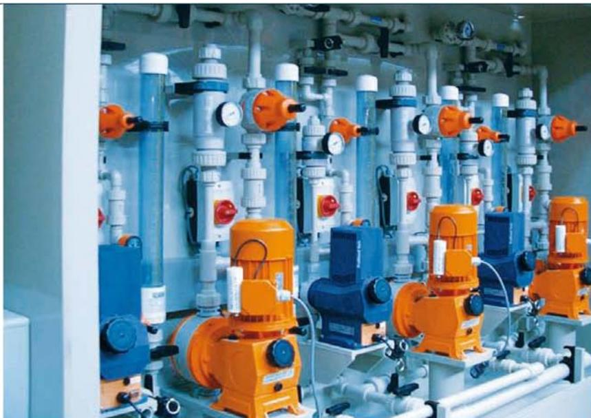
С помощью агрегатов PPLA (систем дозирования витаминов и энзимов в производстве кормов) после грануляции кормов наносятся жидкие добавки. Они обеспечивают точную дозировку дорогих и высокочувствительных добавок. Агрегаты имеют модульную систему и представляют собой единое решение для хранения, перекачки, дозирования и нанесения всех видов добавок, в том числе, например, витаминов, ферментов, ароматических добавок, органических материалов, таких как жиры и масла.
