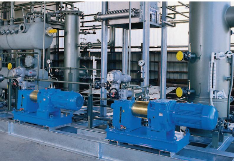
Дозирующие насосы ORLITA® в производственном процессе регенерации гликоля
