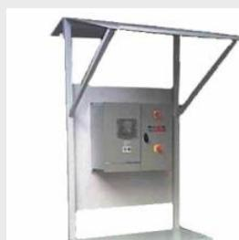
Станция управления (VSD) даёт возможность управлять подачей насоса за счёт изменения скорости вращения привода. Кроме того, станция управления предохраняет насосное оборудование от избыточного момента, перегрева и скважинного давления.
