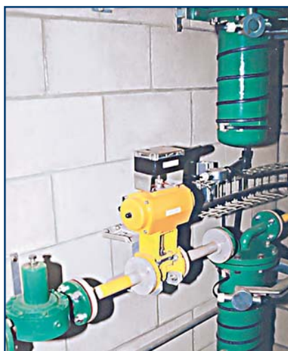
Рис. 3.4. Редукционный клапан 544
