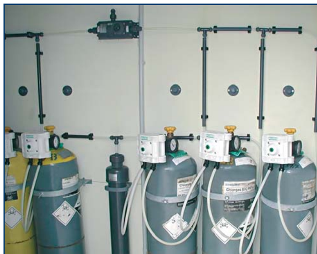
Рис. 2.11-а. Полностью вакуумная система
