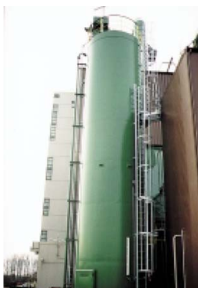
Установка дозирования извести в сооружении по очистке сточных вод.
