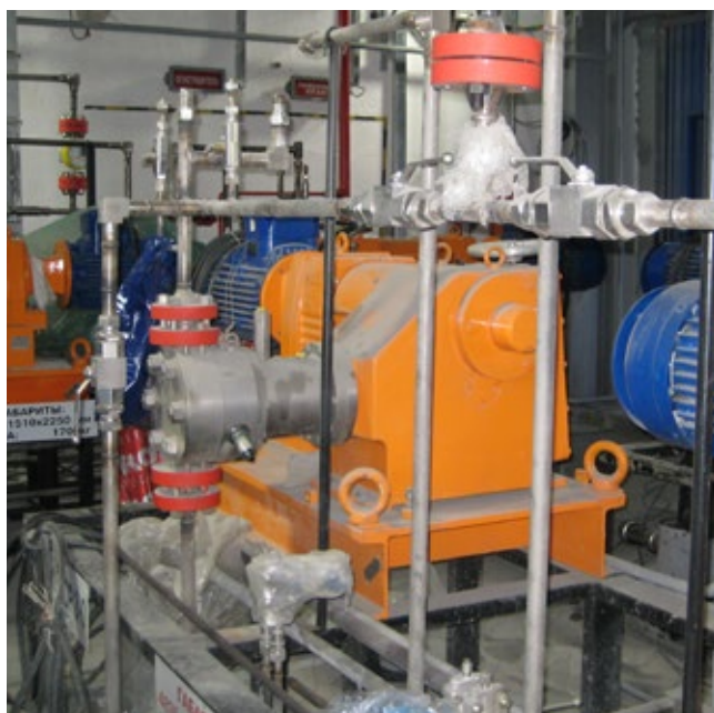
Дозирование присадок, Orlita MFS, ООО «Газпром нефтехим Салават»
