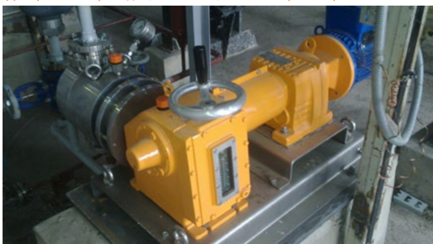
Дозирование присадок, Orlita MFS, ООО «Газпром нефтехим Салават»
