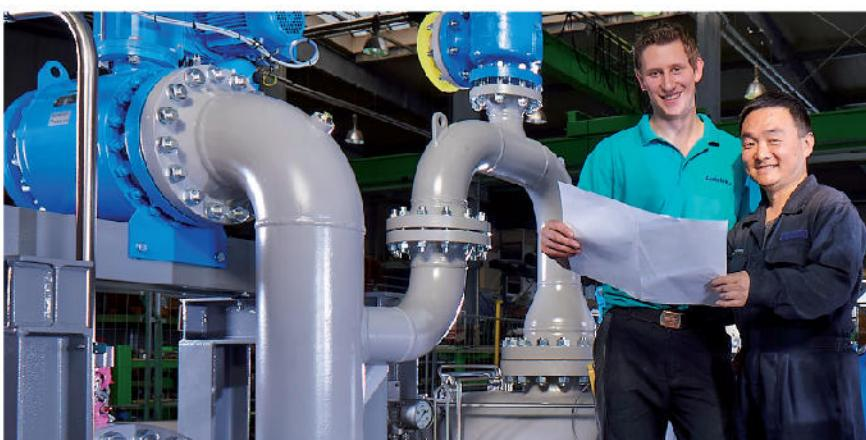
» Привод мультифазных насосов осуществляется с помощью частотно-регулируемого привода, который позволяет оперативно изменить частоту вращения и вывести насос на новые рабочие параметры, исключая необходимость в модификации оборудования.
