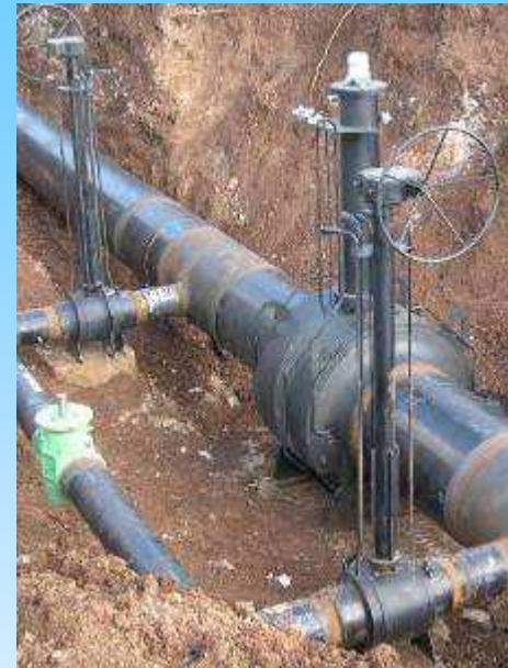
Welded body – цельносварной шаровый клапан
